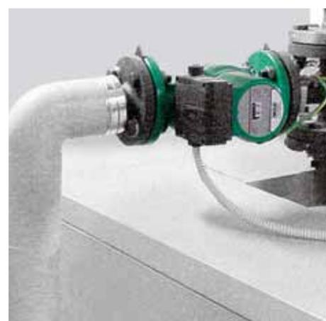
6. Kit di ricircolo (di serie) costituito da due pompe al servizio del corpo caldaia e del condensatore
